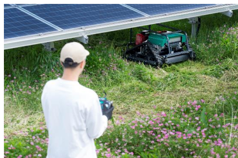
【ソーラーパネルの下での作業風景】
